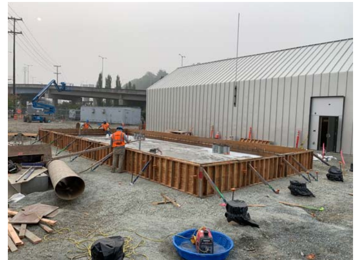
Substation Pad Pours
